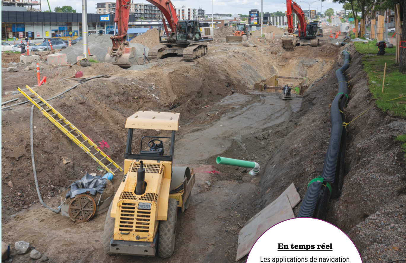
Les travaux souterrains sont en cours sur le chemin des Quatre-Bourgeois.
