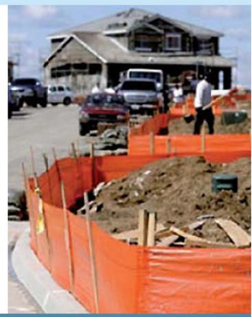
Figure 1. Installation de base de barrières à sédiments pour un terrain résidentiel à bâtir (APEL, 2008)
