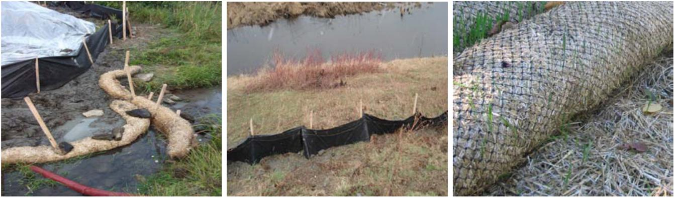
Membrane géotextile attachée à des supports à intervalles réguliers et boudins de pailles
