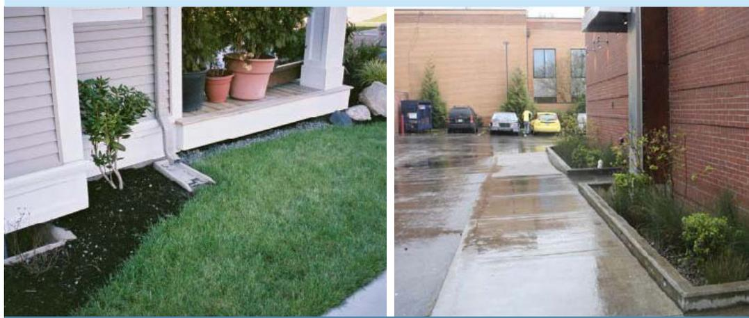
**Figure 2.** Exemples d’application pour le débranchement des drains de toit (TRCA, 2010)
