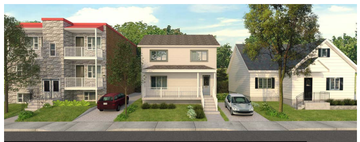
IMAGE 3 – PHOTOGRAPHIE DU BÂTIMENT QUI FAIT FACE À L’IMMEUBLE VISÉ PAR LA DEMANDE ET SES DEUX BÂTIMENTS ADJACENTS
