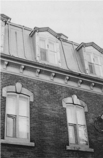
49. Insertion d'éléments de pierre formant les linteaux et les appuis des fenêtres.
