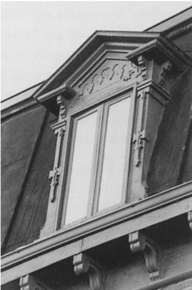
33. Corniche à simple soffite, gouttière soutenue par des consoles de bois et retenue par des attaches.
