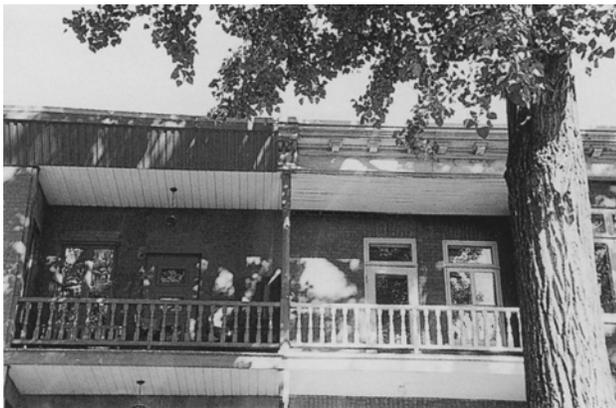
38. La disparition des détails de la corniche et le remplacement des éléments d'origine par des matériaux modernes, sur la partie gauche, portent atteinte à ce bâtiment en l'appauvrissant.
