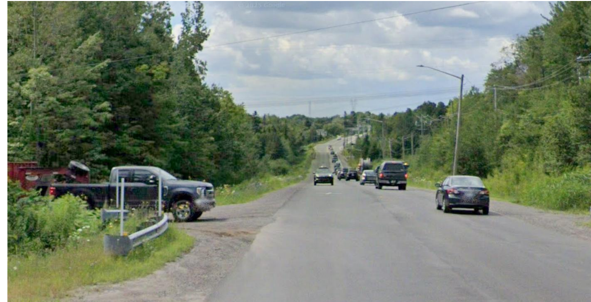
Situation actuelle, rue de la Faune Vue vers l'ouest
