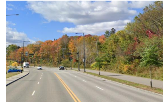
Rue de la Faune, en face du Parc-O-Bus
