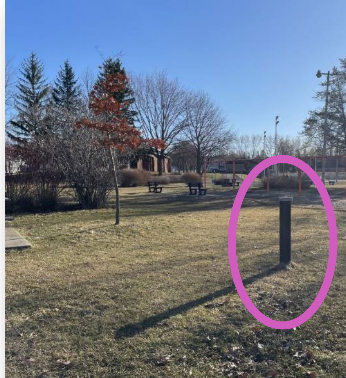
Puits d'observation pour échantillonnage de l'eau
