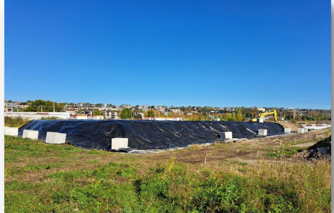
Recouvrement des matériaux en vrac
