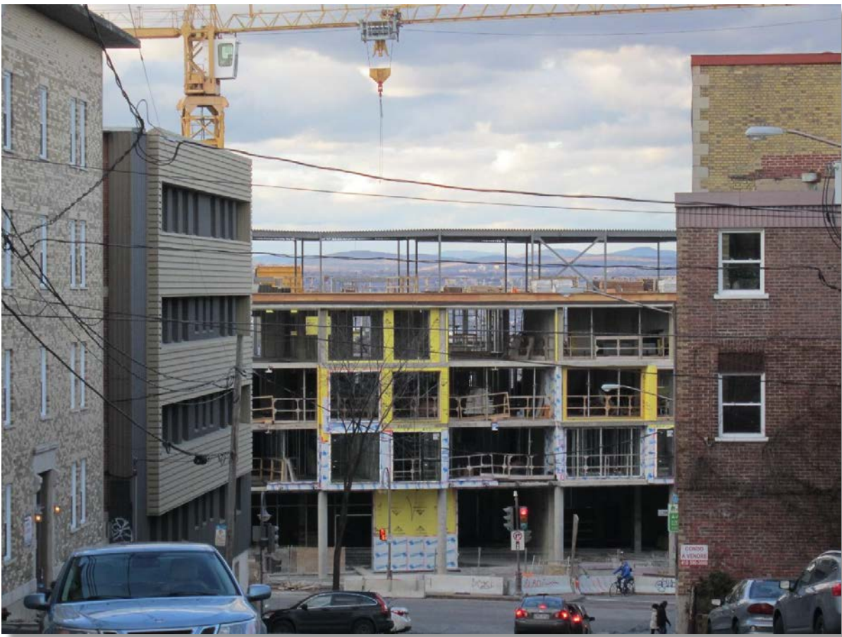
Vues depuis la rue Lockwell en novembre 2014 et en novembre 2015
