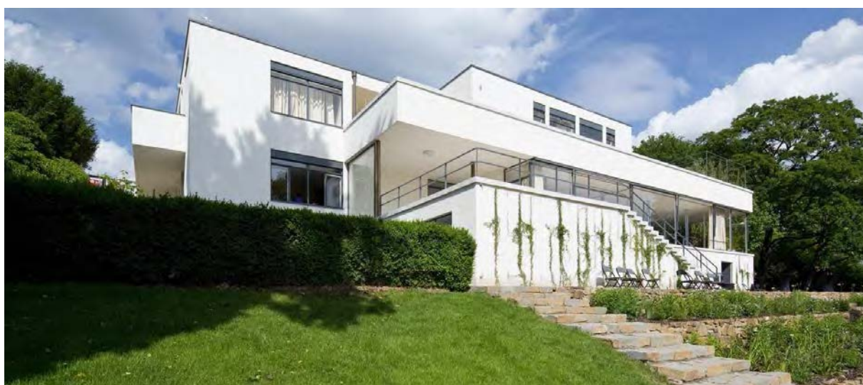
Figure 48. Construction en pente. Villa Tugendhat de Mies Van Der Rohe, architecte (ici, on voit l'intérêt de ce bâtiment de trois étages « en pente », mais d'un seul étage sur rue – c'est comparable à ce qu'on voit du CÉGEP Sainte-Foy, à Québec, à partir du chemin Sainte-Foy et ça exprime l'une des caractéristique de la ville de Québec, de ce qu'on peu y construire. Bien sûr les bâtiments diffèrent, mais le résultat peut être mis en relation – voir la vidéo en ligne, précédemment identifiée dans cette annexe).
