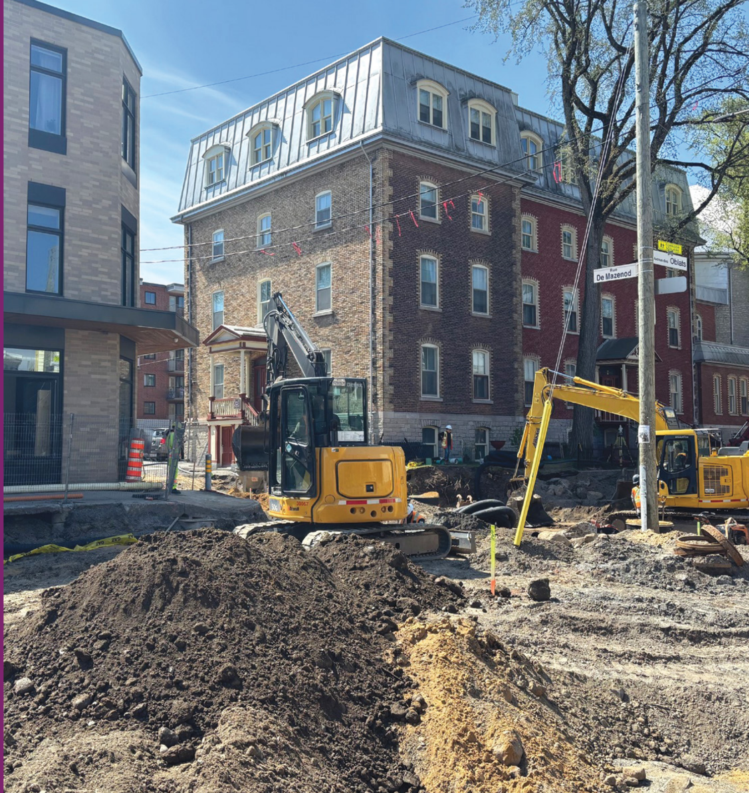
Exemple d'un chantier majeur • Rue Saint-Vallier Ouest
