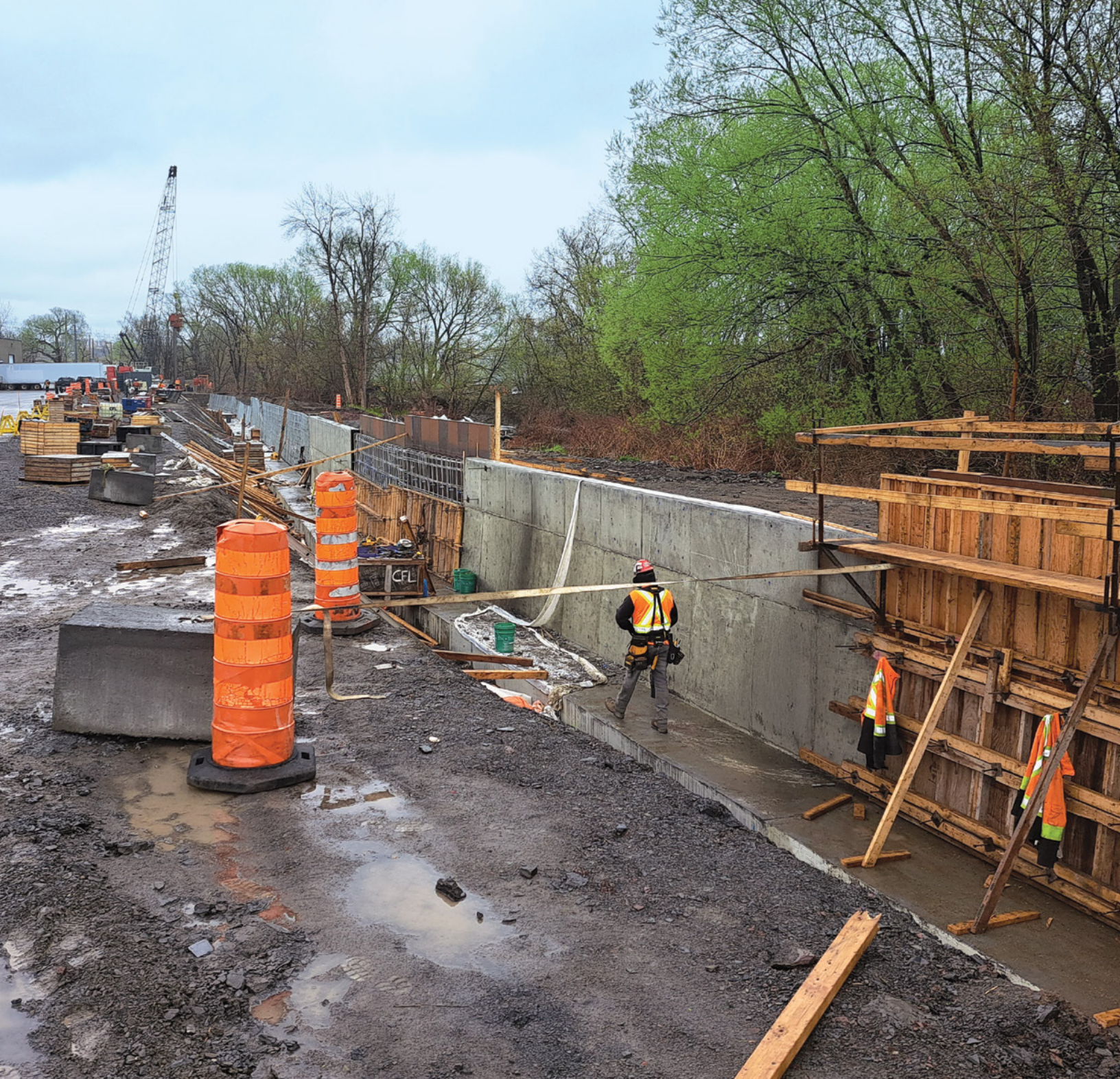
Exemple d'un chantier majeur • Ouvrages anticrues de la rivière Lorette
