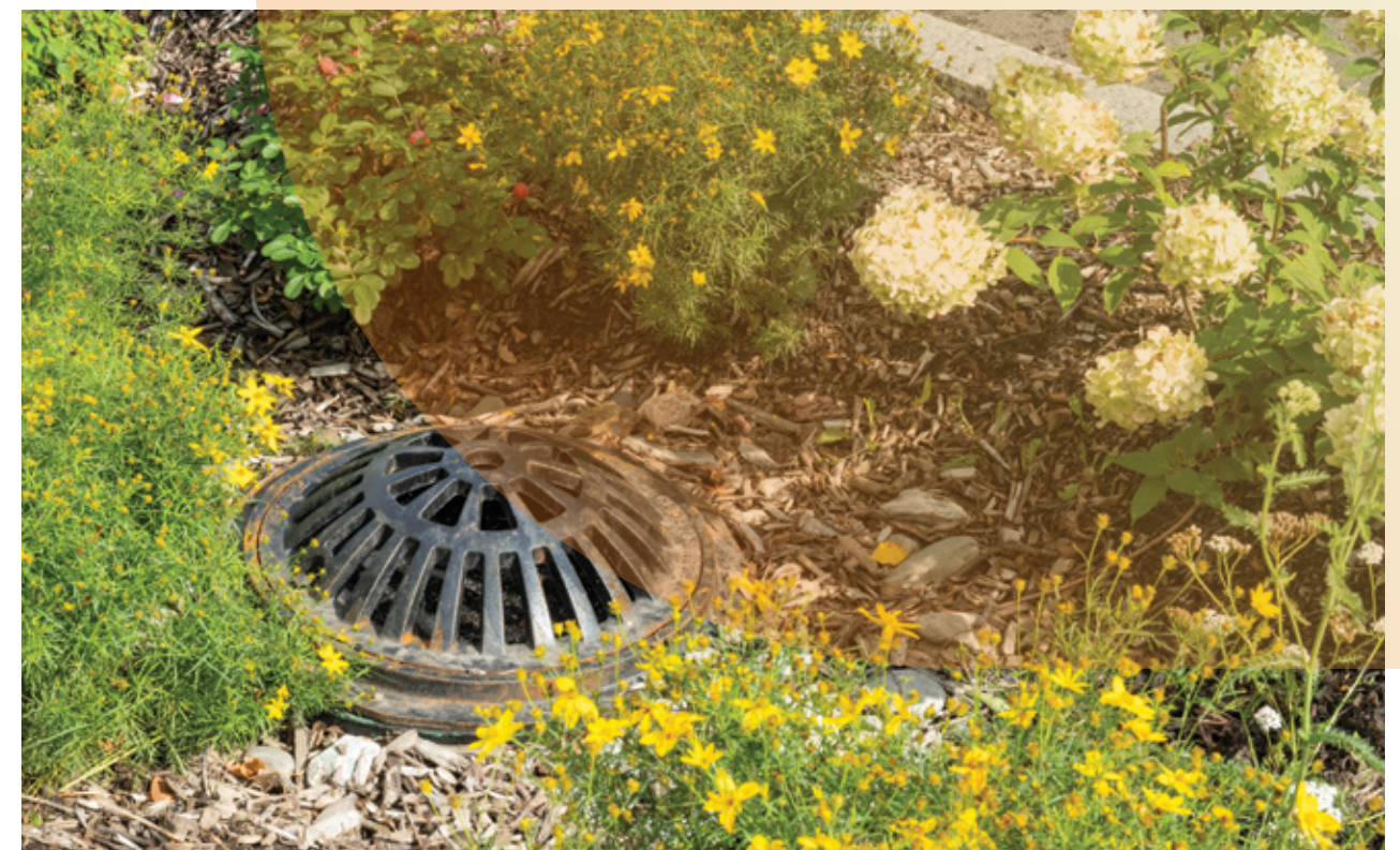
Noue végétalisée sur la rue Champagnat
